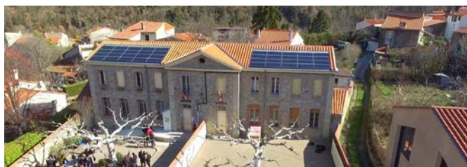
Mairie de Taurinya (06) équipée par Conflent Énergie.
